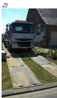
Abb. 1: Elastische Verformung einer Platte unter schwerer Last
